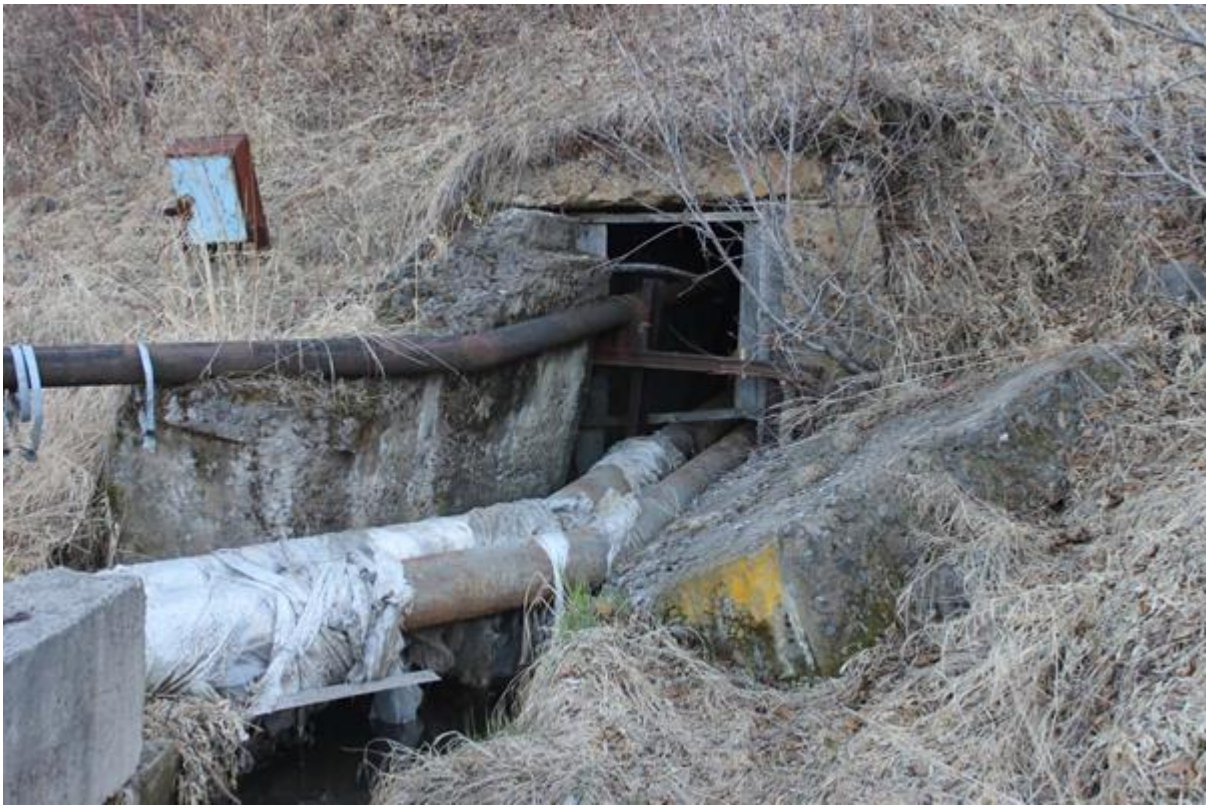
Рисунок 5.3.3. Водопрпускная труба на ручье Нанте под ж.д. насыпью
